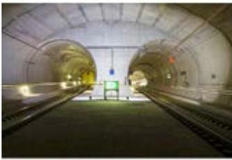
8,5 bis 13 Meter in den Fels geschnitten. Dazu kommen alle 330 Meter die 40 bis 70 Meter langen Quertunnel - aus Sicherheitsgründen: so können Menschen im Katastrophenfall in die Nachbarröhre flüchten. Zum Teil liegt darüber die beeindruckende Felsmasse von bis zu 2300 Metern. Mit diesem europäischen Großprojekt sollen weite Teile des Güterverkehrs zwischen dem Nordseehafen Rotterdam und Genua am Mittelmeer von der Straße auf die Schiene verlegt werden.
